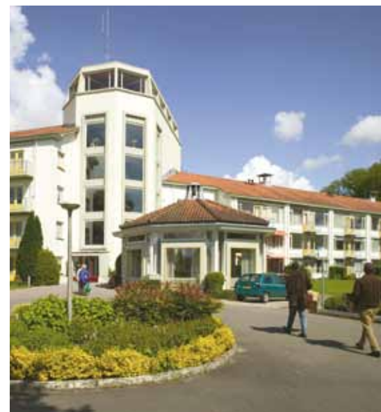
Onbezorgd wonen in een appartement in de Nieuwenhof in Voorst
