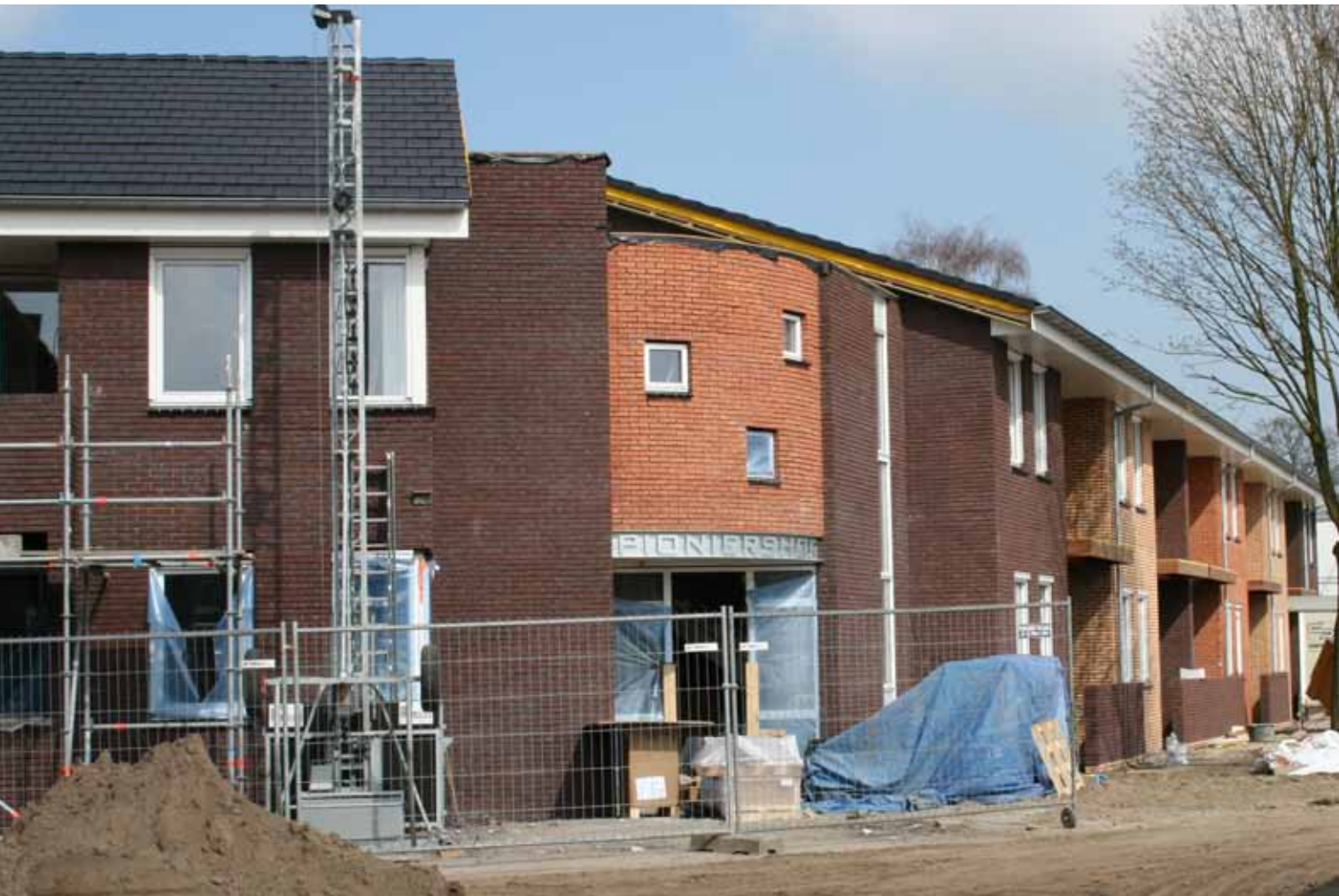
Groepswonen Stationskwartier Twello in aanbouw
